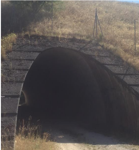
Figure 47: Photographie de l'ouvrage à aménager
