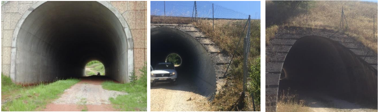
Figure 55 : Vue des trois ouvrages qui sont franchis par les ongulés. A Gauche sentier passant sous l'autoroute A20, Au milieu et à Gauche, sentier passant sous l'autoroute A20.
