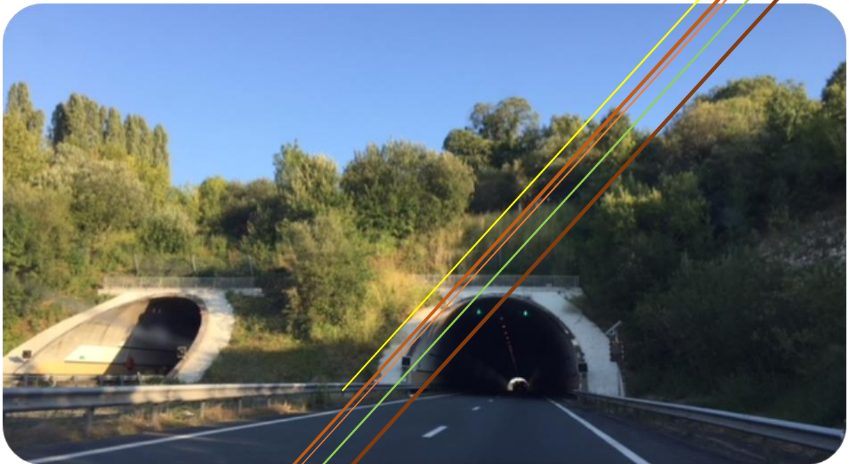
Tunnel de Noailles (46)
