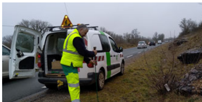
Les équipes techniques des gestionnaires d'infrastructures routières peuvent apporter un appui à la pose, l'entretien et la dépose des dispositifs de sécurisation des voies.
