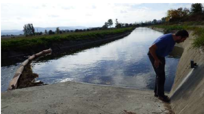
Les canaux non-navigués peuvent être équipés de dromes qui guident la faune vers des rampes de sortie. Peu fréquentées par le public, elles peuvent être suivies par photopièges.
