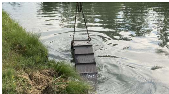
Puisque la faune ne peut être guidée vers les échappatoires, les échelles doivent être régulièrement disposées dans les canaux navigués dépourvus de berges naturelles.
